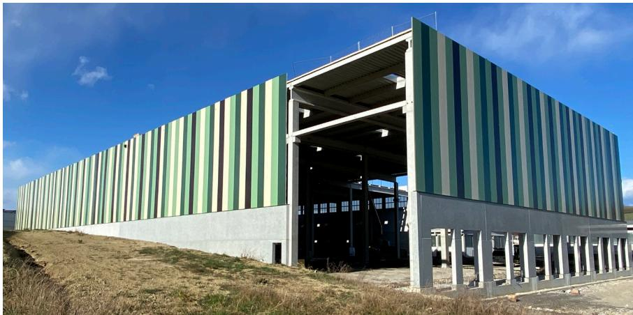
La perfetta configurazione del giunto rende piacevole e uniforme la superficie dell'involturo edilizio, e consente al pannello di abbattere considerevolmente i ponti termici che, come è noto, sono causa di dispersione energetica e formazione di condensa.
