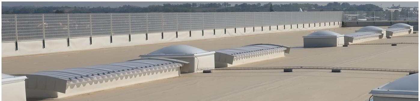
Le coperture **DECK** sono prodotte in continuo con un supporto metallico in acciaio zincato e un supporto all'impermeabilizzazione in cartonfondo bitumato, sul quale potranno essere applicate guaine impermeabilizzanti e strati per la protezione della copertura.
