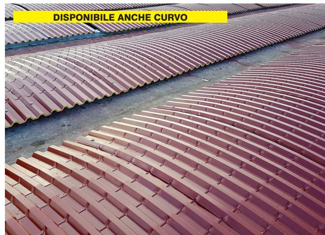
**Isogrek H28** è un pannello monolamiera ottenuto dall'accoppiamento di un resistente profilo metallico h 28 mm ad uno strato di poliuretano ad alta densità schiumato in continuo. Modulare, leggero, isolato e resistente, si adatta ad ogni tipo di impiego per il tamponamento dell'involucro esterno dell'edificio.
