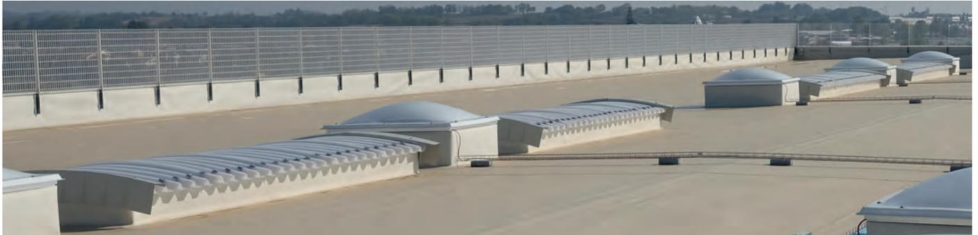
Le coperture **DECK** sono prodotte in continuo con un supporto metallico in acciaio zincato e un supporto all'impermeabilizzazione in cartongesso bitumato sul quale potranno essere applicate le diverse guaine impermeabilizzanti e strati per la protezione della copertura.
